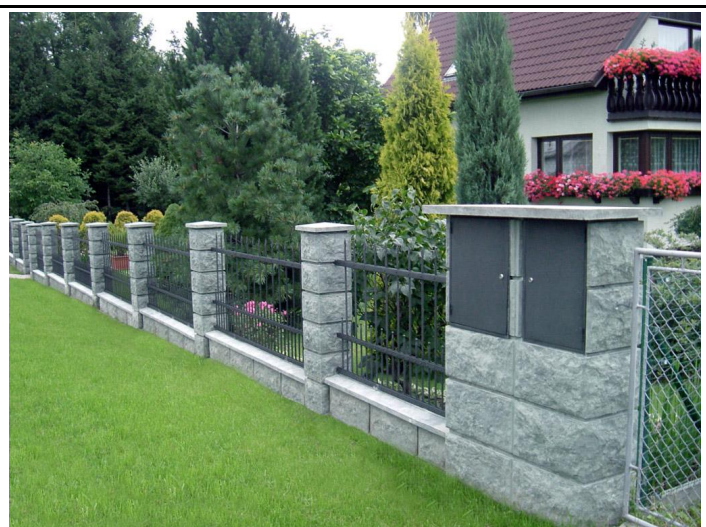
přístřešek PL-ER 2003 (plynoměr+rozvaděč) (foto)
